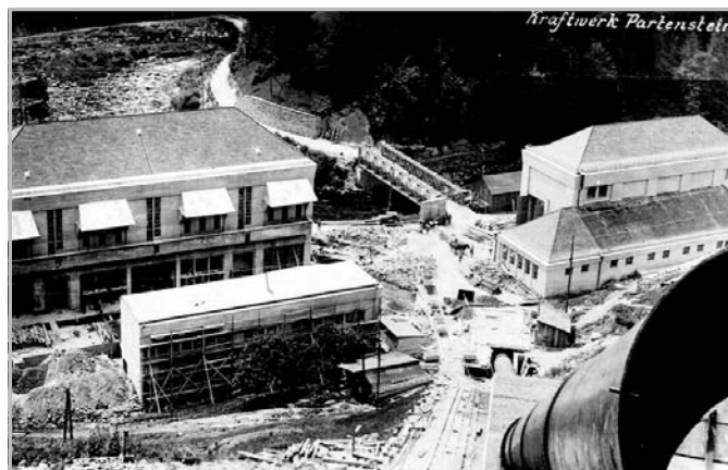
Kraftwerk Partenstein Das Kraftwerk Partenstein wurde in einer wirtschaftlich angespannten Zeit gebaut und leitete das Ende der Holz-Trift ein.
